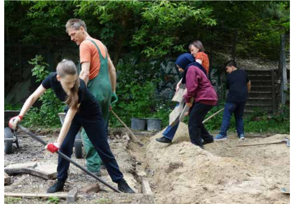
Abb. 67 Abbruch der großen Kantensteine
