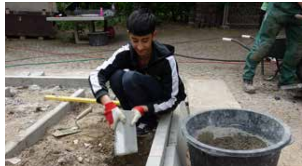
Abb. 64 Shahan setzt einen Kantenstein ein
