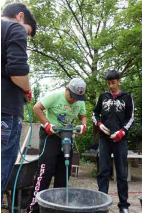
Abb. 60 Stefan mischt Mörtel an
