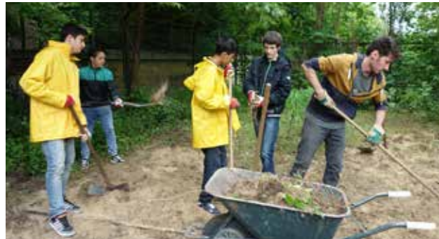
Abb. 58 Sandfläche fürs Pflastern vorbereiten
