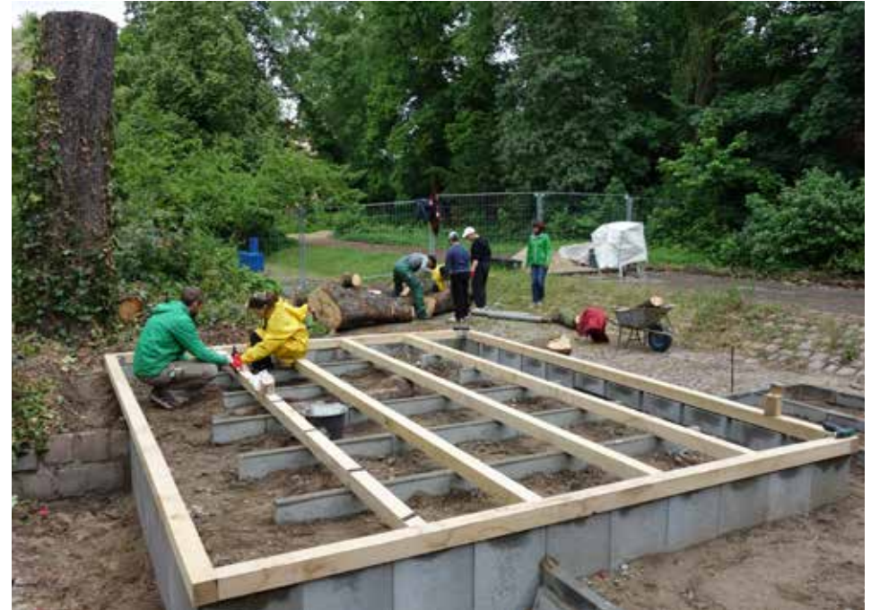
Abb. 56 Unterzüge der Bühne schrauben
