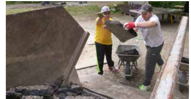
Abb. 69 Stefan und Alex entsorgen Asphalt
