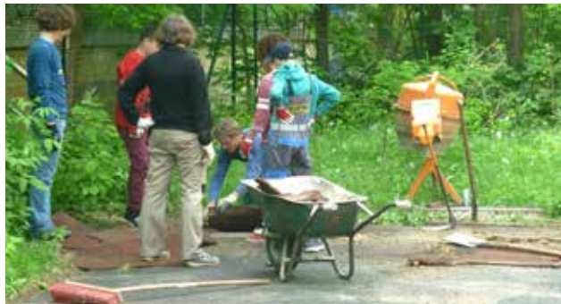
Abb. 16 HPDM-Fläche (Laufbahn) abbrechen
