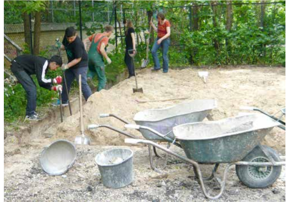
Abb. 72 Abbruch der Kantensteine
